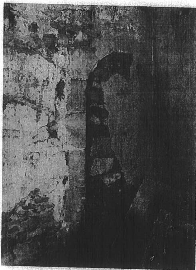
Fig.94 : Porte P5 dans le mur nord M3
