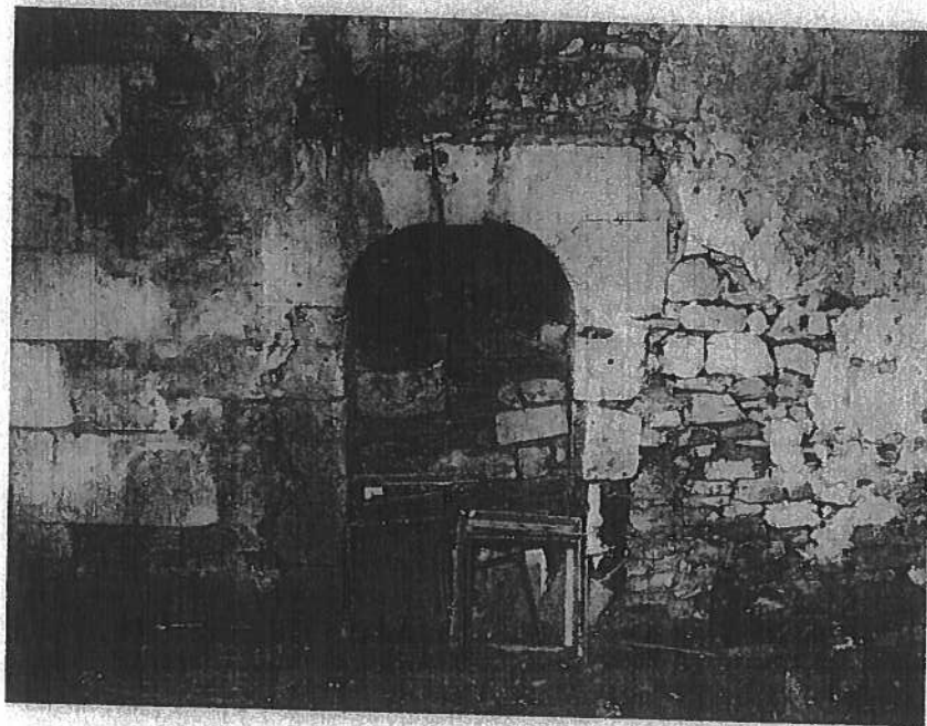
Fig.93 : Porte P4 dans le mur nord M3
