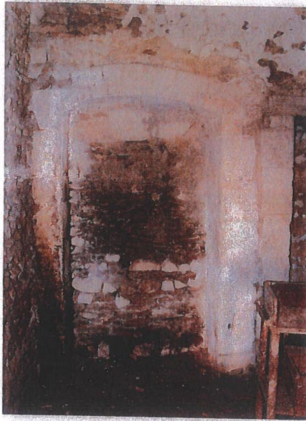
Fig.91 : Porte P2 dans le mur nord M3
