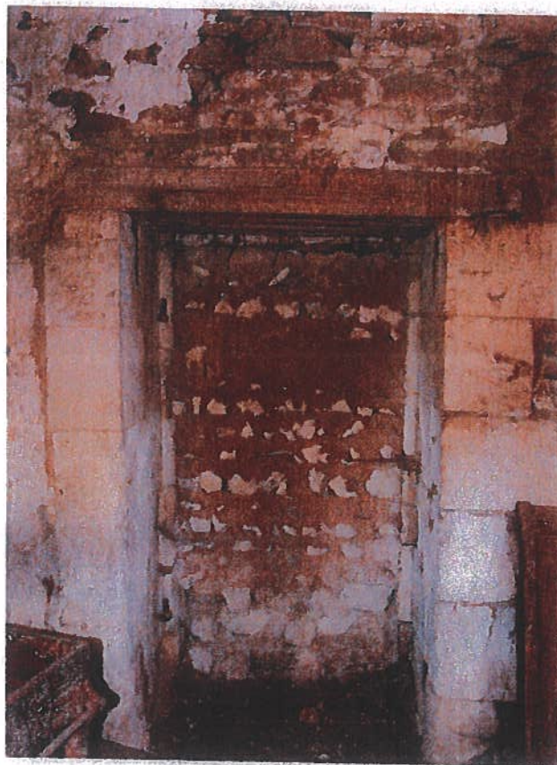
Fig.92 : Porte P3 dans le mur nord M3
