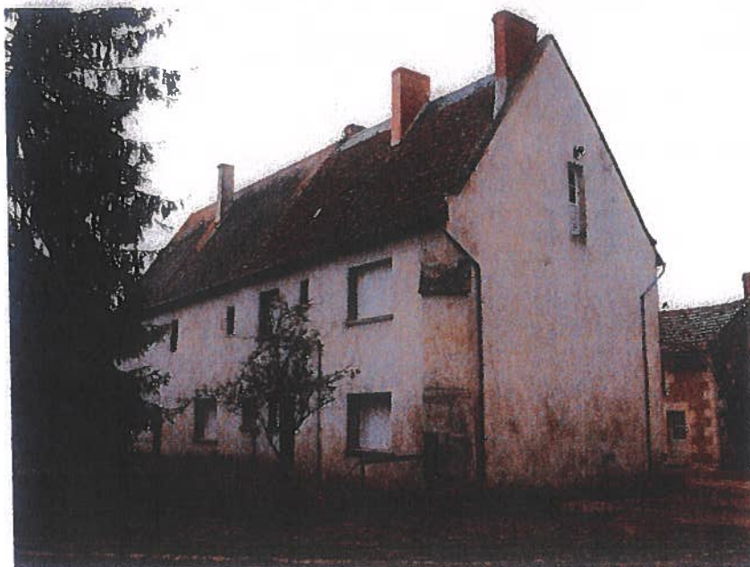
Fig. 105 : Façade nord et est du corps de logis de Saint-Jean-de-l'Habit
