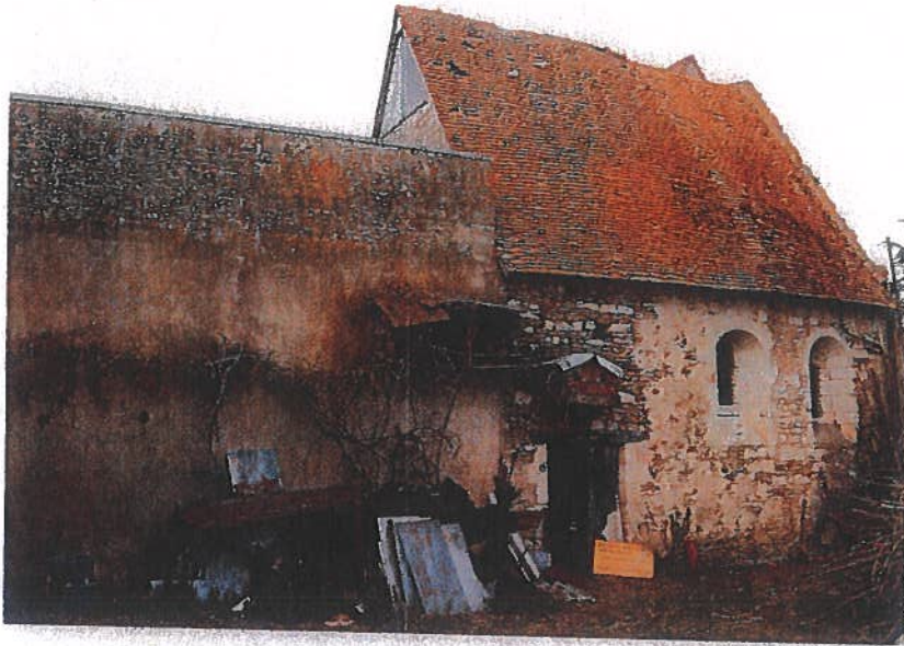
Fig. 89 : Porte P1 en façade sud
