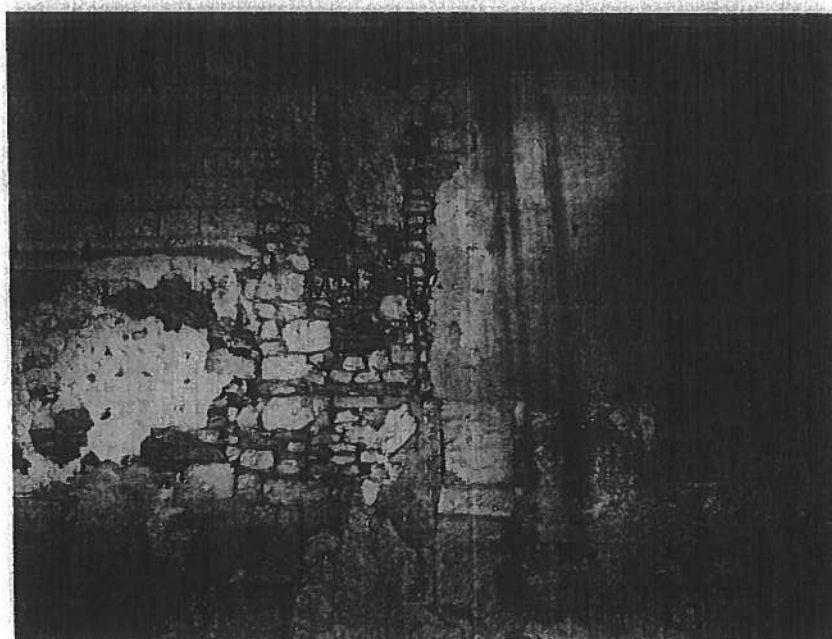
Fig. 98 : Interruption des maçonneries attribuées à la phase I par un arrachement de mur M14 ?
