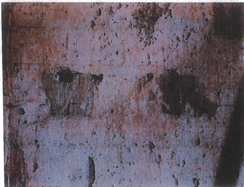
Fig. 100 : Éléments bûchés au ras du parement de M4.
